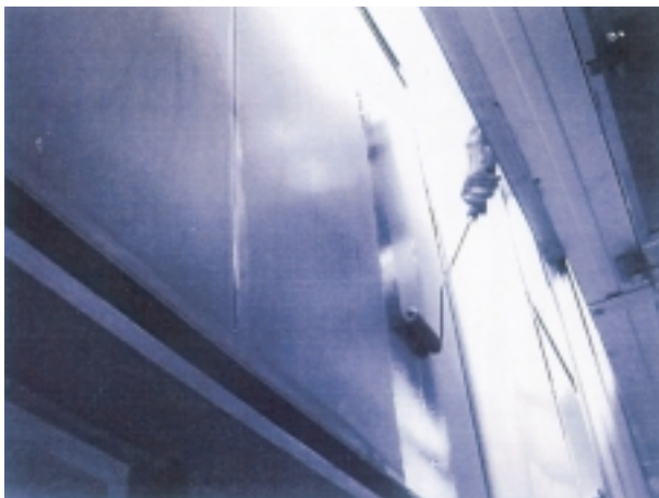
写真6 「ビル外壁塗装」一区画パネル (高さ1.8m × 幅2.4m)
