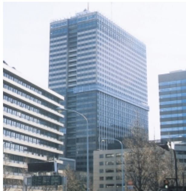
写真1 超高層ビルの塗装改修例
