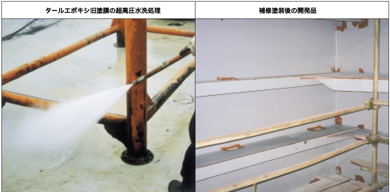
写真4 バラストタンクでの新規補修塗装工法（開発品）の適用例
