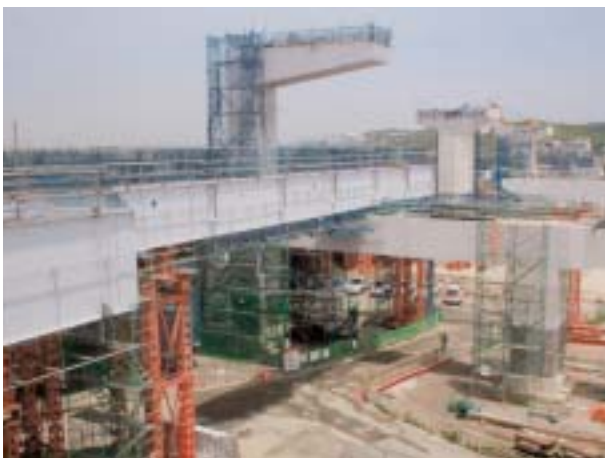
写真1 建設中の都市高速5号線
