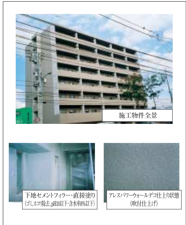
写真3 仕上がり施工例
