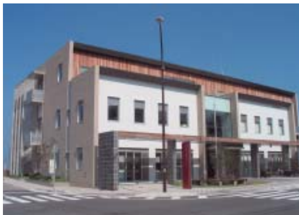
淡路町保健福祉センター外観
