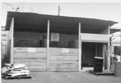
汚泥のリサイクル (尼崎工場)
