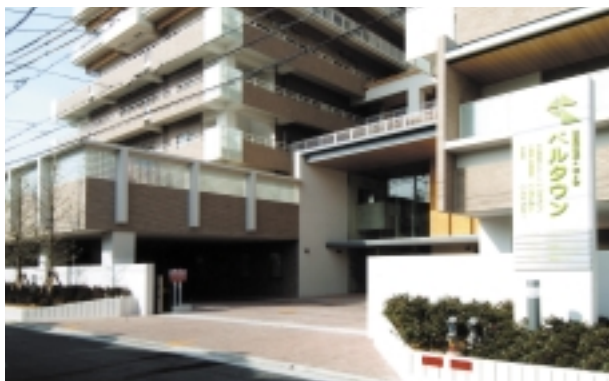
写真2 エントランス外観
