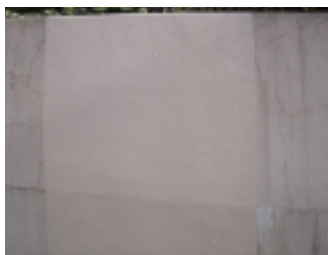
写真6 施工例2 (工場のコンクリート壁面)
