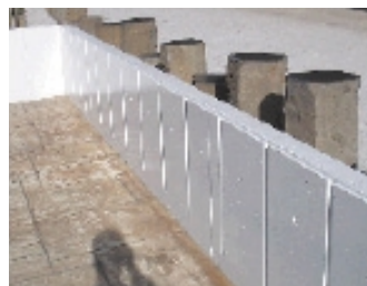
写真5 施工例1 (公園のコンクリート壁面)
