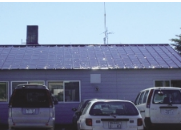
写真1 スーパーシリコンルーフペイント標準色と遮熱色を塗り分けた物件写真(塗色:コーヒーブラウン色)
