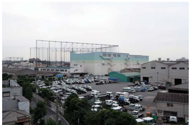
写真3 完成写真（近隣のマンションから）
