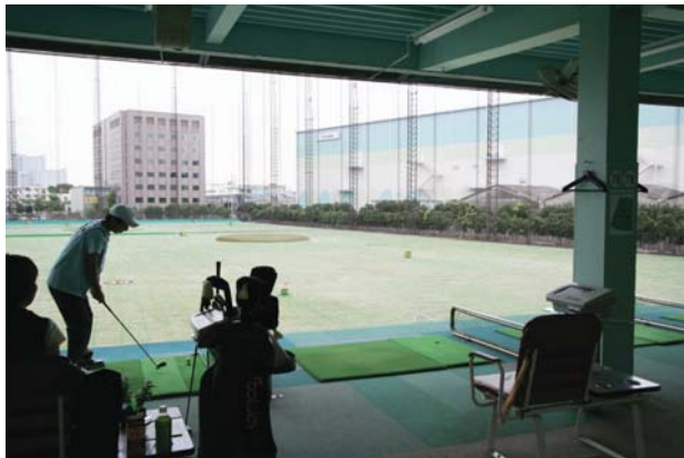
写真1 完成写真（ゴルフ練習場側）
