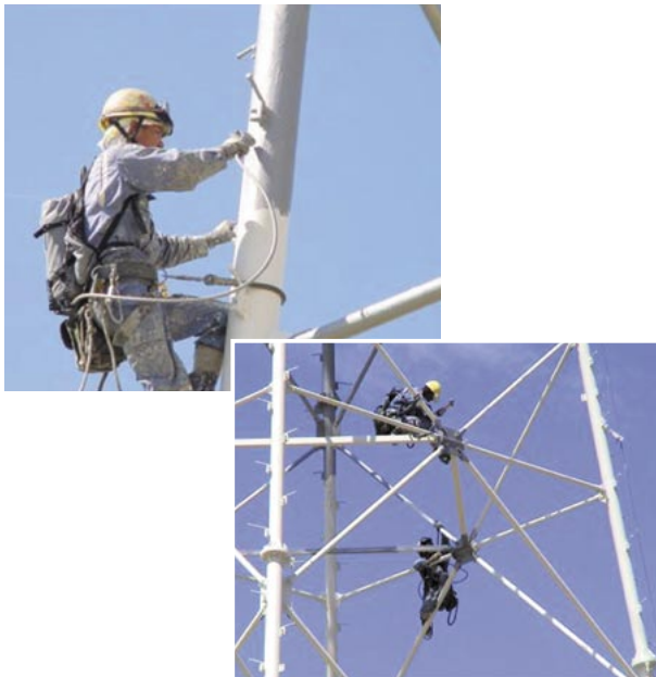
写真15 塗装作業風景
