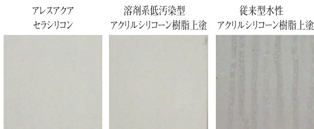
写真1 屋外バクロ試験6ヵ月後の雨筋汚染状態
