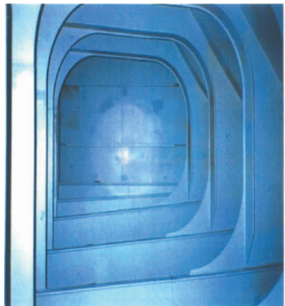
写真2 塗装後のBWT内部
