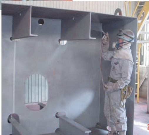
写真3 汎用エアレス塗装機（圧縮比：1/45）と試験部材への塗装状況
