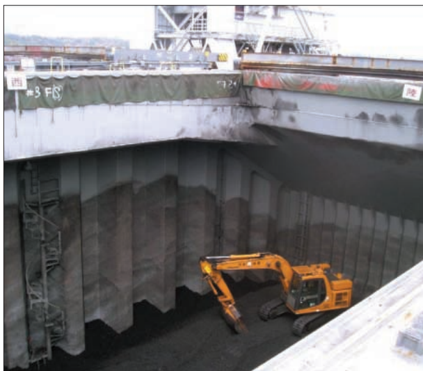
写真2 荷揚げ作業状況 重機による機械ダメージが発生する
