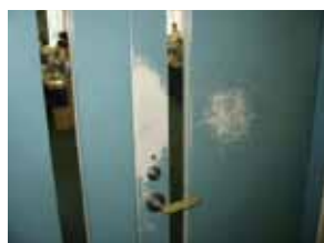
<塗膜が剥離した鉄扉> <皮脂軟化・剥がれの概略図>
