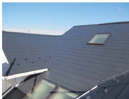
写真3 「アレス水性エポレジン」を使用した窯業屋根塗り替え試験
