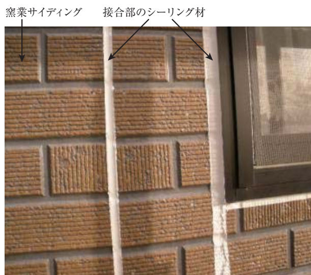
写真1 シーリング材の充填状況
