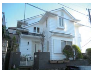
水性モノトーン仕上げ(全景) ~アレスアクアセラシリコン~
