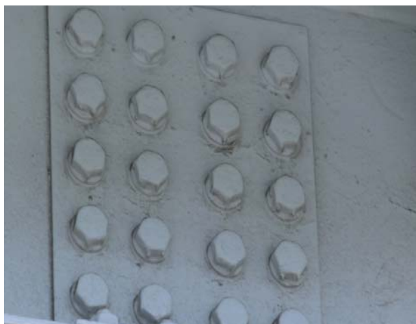
写真4 水性重防食塗料システム施工の添接部
